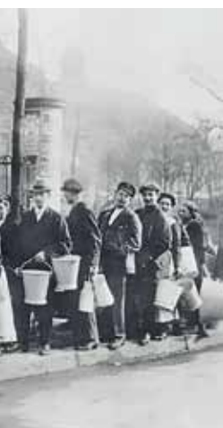
Ihren ersten „Ernstfall“ meisterten die Straßenpumpen während des Kapp-Putsches 1920
