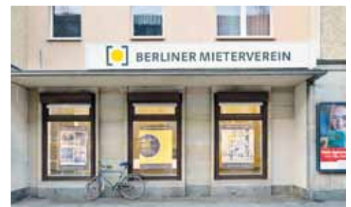
Beratungszentrum Frankfurter Allee in der Frankfurter Allee 85
