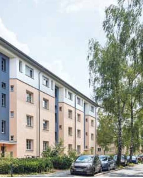
Bei der Fassaden- dämmung sind pauschale Vor- gaben des Förder- gebers nicht sinn- voll: Gedämmtes Gebäude der „Mär- kischen Scholle“
