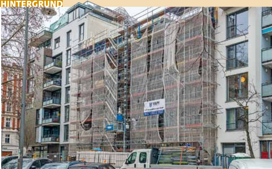
Baustelle Calvinstraße 21 heute; letzter Mieter Czapara und Rechtsanwalt Müller
