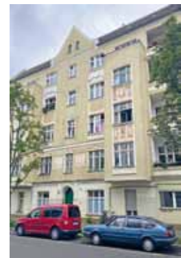
Geister des Sanierungsstaus: Im Dachstuhl heult es, Balken knarren – in der Ueckermünder Straße 15 musste jetzt in einer Wohnung die Decke gestützt werden
