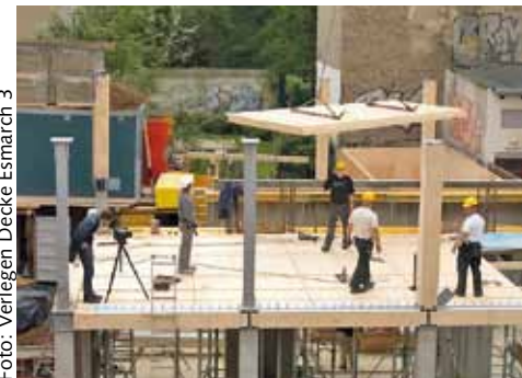
Foto: Verlegen Decke Esmarch 3
